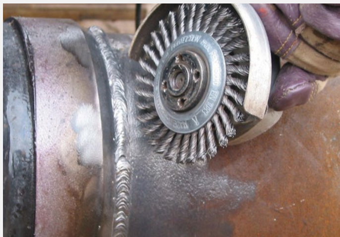
Exaktes Arbeiten erfordert hochqualitative Werkzeuge
